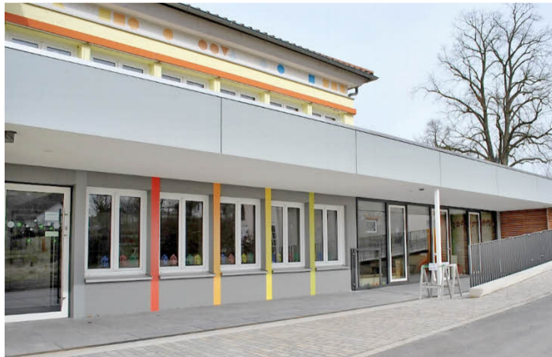
Nach kurzer Bauzeit konnte der Krippenanbau bezogen werden, derzeit werden dort 13 Kinder betreut.
